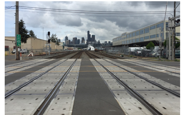
Cruce ferroviario en S Lander St
